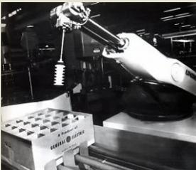
En 1962 la primera de estas máquinas fue instalada en la línea de producción de General Motors, con la finalidad de ensamblar motores, convirtiéndose en la primera cadena de producción automatizada de la historia.
